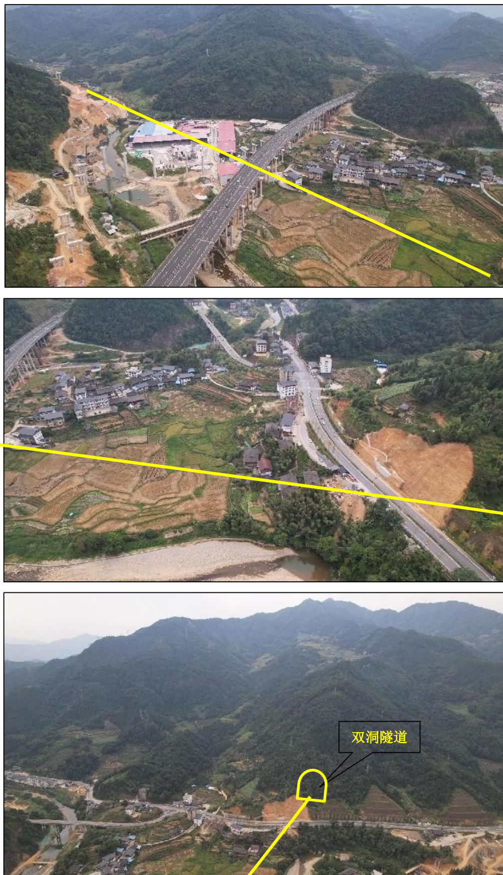
图 2.4-6 双洞枢纽互通主线桥桥位航拍
