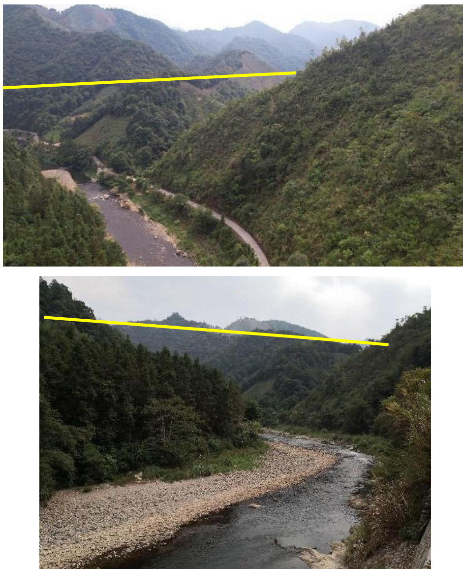
图 2.4-7 青明特大桥桥位航拍
